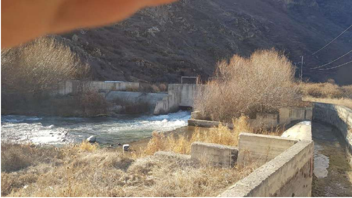
Şəkil 2 Mirik Kiçik Su Elektrik Stansiyasının suqəbuledici qurğunun ümumi görünüşü
