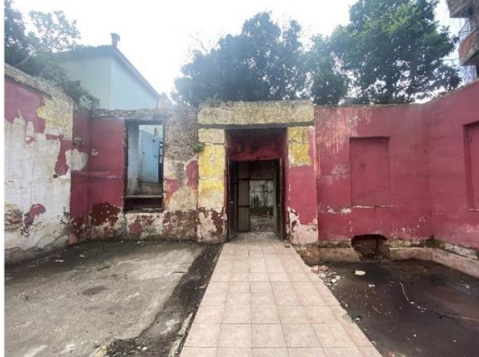
Şekil 11: Konutun güneydoğu cephesinden genel görünüm
