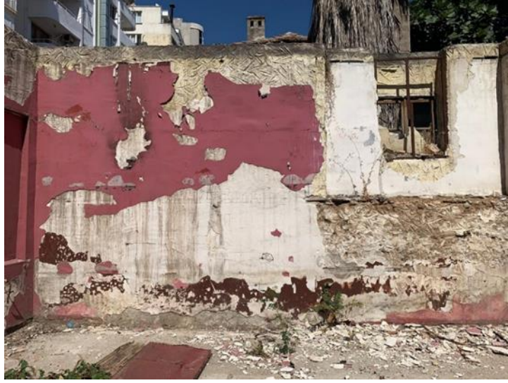
Şekil 9: Konutun kuzeydoğu cephesi
