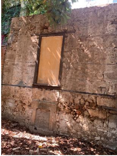
Şekil 12: Konuta ait bahçenin güneydoğu duvarındaki basık kemerli niş
