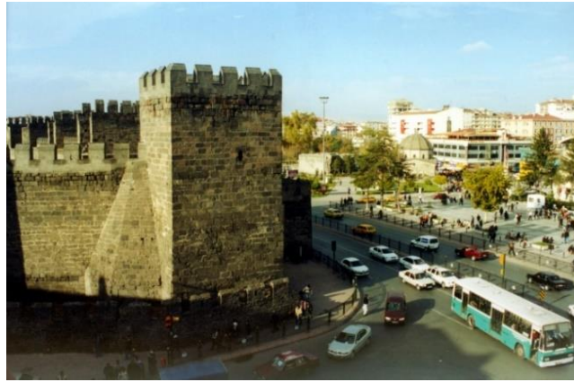
Şekil 4- Kayseri Kalesinde restorasyon öncesi hava kirliliği ve trafik etkisiyle oluşan kirlilik (H. Kozlu arşivi)
