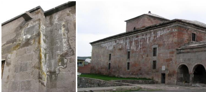
Şekil 3- Kayseri Gevher Nesibe Sultan Darüşşifasında 1980'li yıllarda uygulanan çimentolu onarımlar sonucu duvarda nem ve tuz problemi, Şekil 4- Zincidere Rum Kilisesinde tuzlanma problemi (H. Kozlu arşivi)
