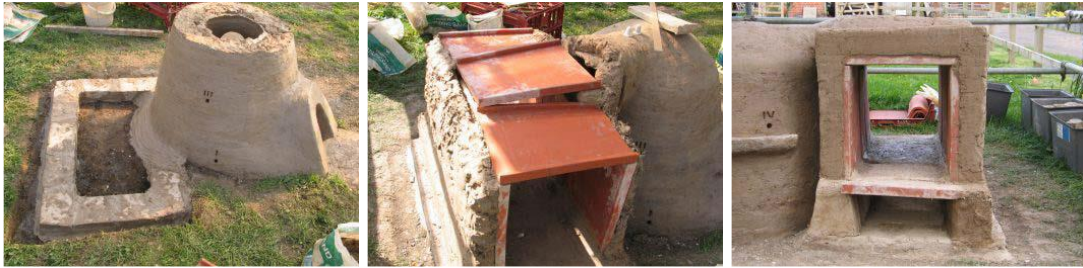
Şekil 14 Tavlama fırınının yapım aşamaları.
