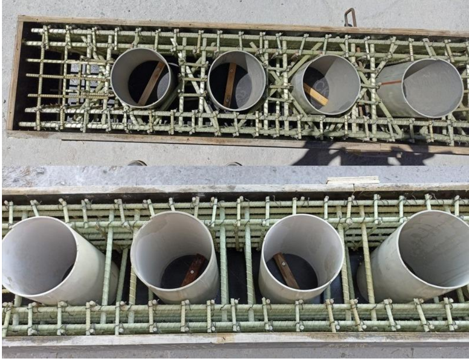
Şekil 2. Beton döküm öncesi donatı ve kalıp detayı
