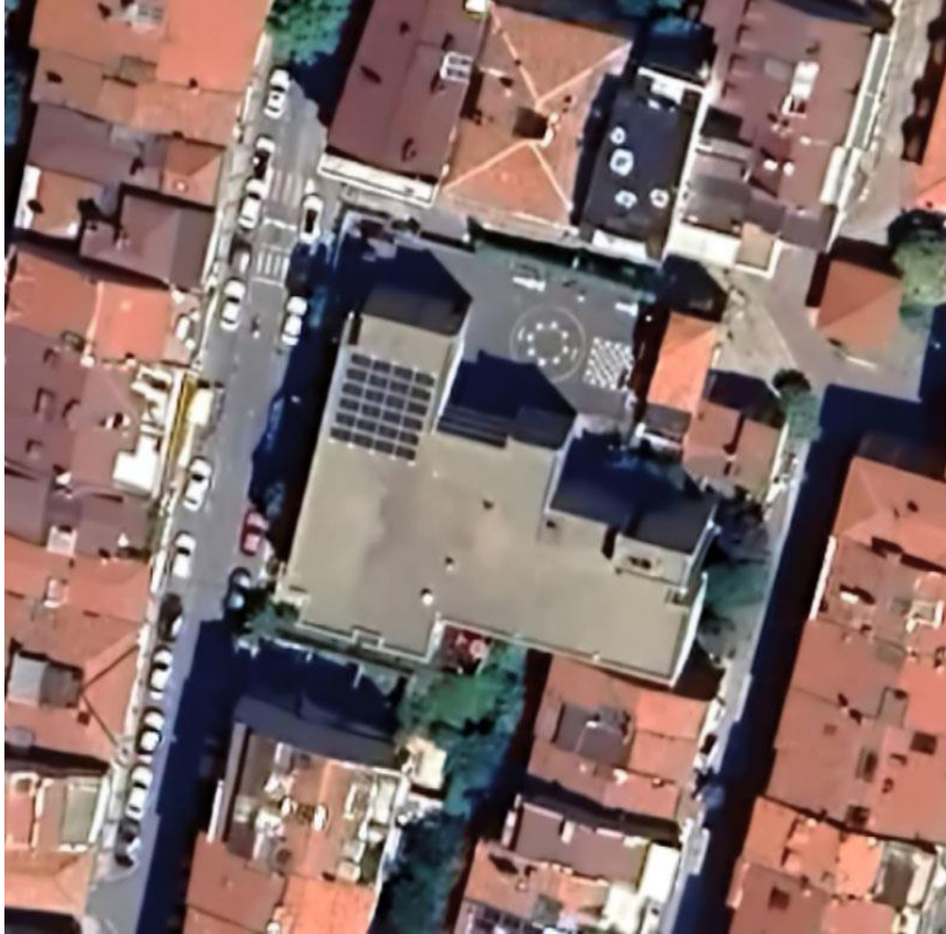
Şekil 2. Beşiktaş İlkokulu'nun teras çatısının uydu görüntüsü
