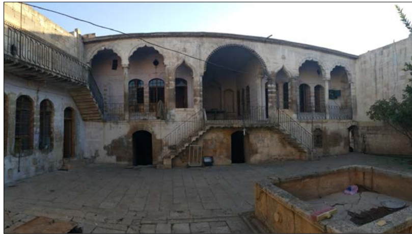
Şekil 4. Karaçizmeliler Evi güney cephesi.
