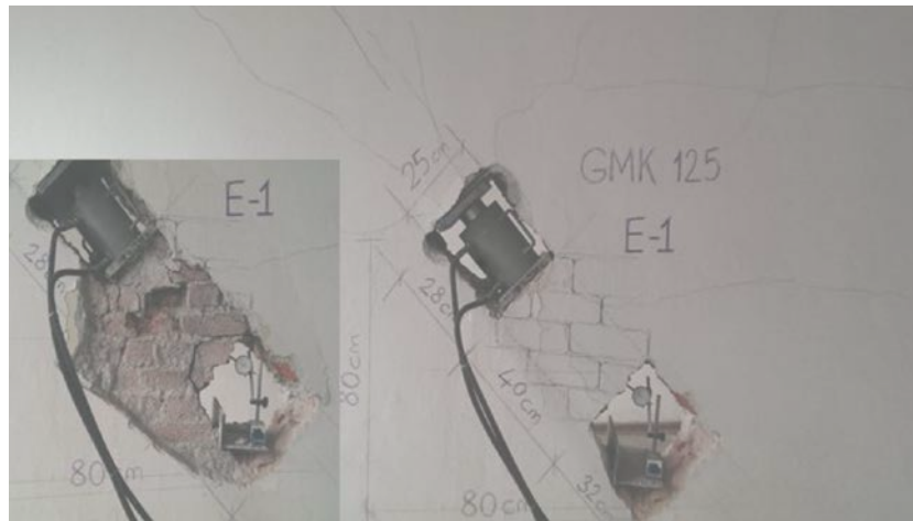
Şekil 4. Bina yükünü dikkate alan çift mesnetli kombine yük altında duvar göçme şekli
