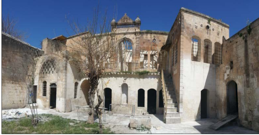
Şekil 5. Karacizmeliler Evi kuzey cephesi.
