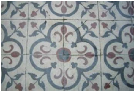
Resim 27. İstanbul İliç Han'da ve Havran Belediye Binası'nda karosiman kullanımı
