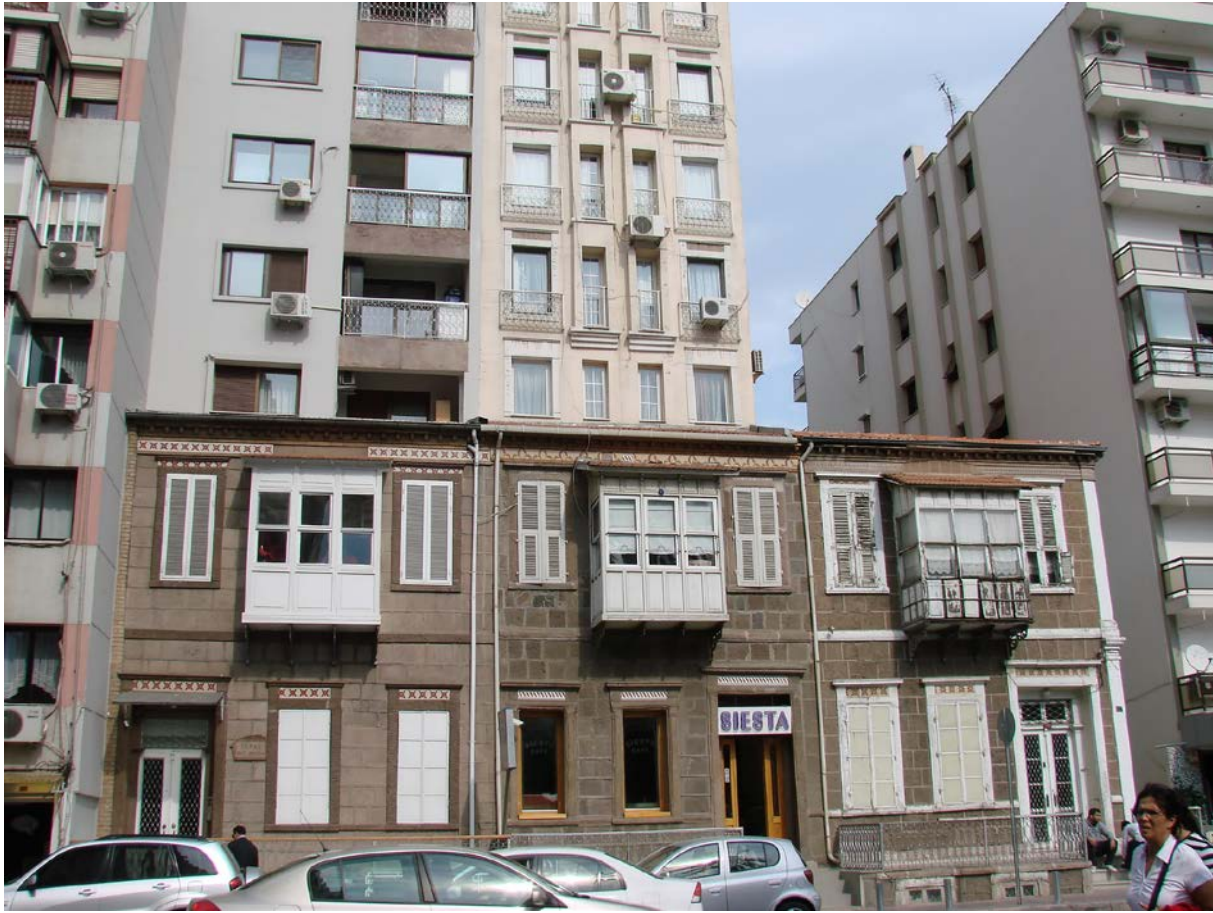
Resim 14. Üçüz ev cephesinde karosiman kullanımı
