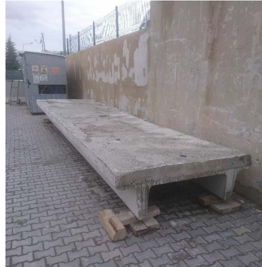
Şekil 4. Kaplama Betonlu TT-Kiriş
