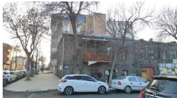
Şekil 38 Zemin katı kafe üst katı konut olarak kullanılan Ruslar dönemine ait yapı
