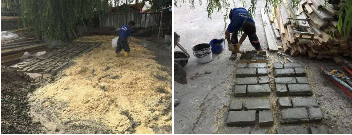
Şekil 3. Ayaş- Şeyh Muhittin Camii kerpiç hazırlanması
