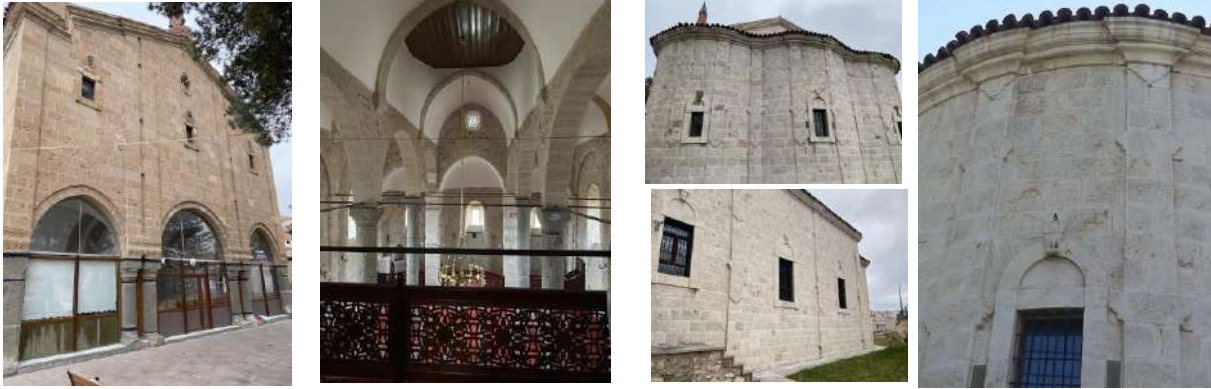
Şekil 4. Aya Yorgi Kilisesi cephe ve iç mekânı (2021, L. Kaderli ve K. Cesur arşivi)
