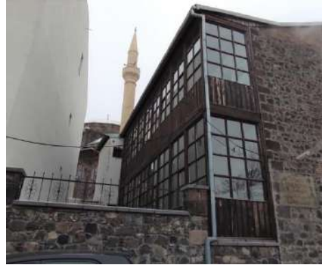
Şekil 25 Camekâna dönüştürülmüş veranda ve balkon, 2021 (yazarın arşivinden)
