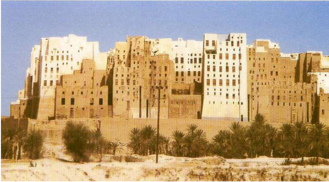
Şekil 1. Yemende çok katlı kerpiç yapı
