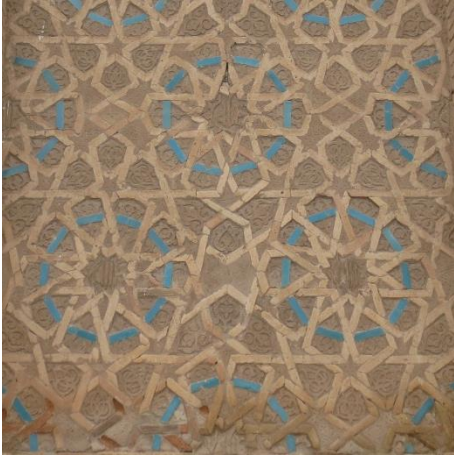
Mümine Hatun türbesinin şebekeli dış yüzeyi
